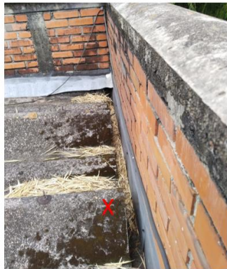
Techos: Canales obstruidas y tejas rotas
