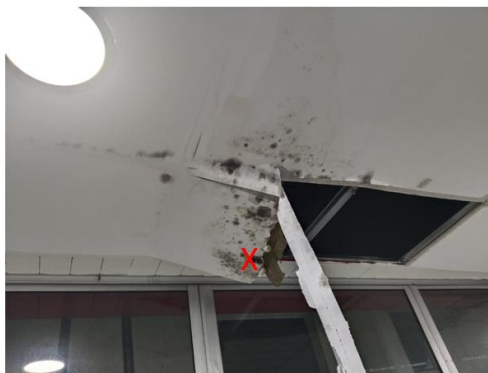
Local Comercial EDS: Un alto porcentaje de las Oficinas se encontraron con goteras, desplomándose parte de techos.
